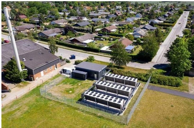
Abbildung 29: 1, 2 MW Luft-Wärmepumpe in Slagslund Dänemark (Quelle: PlanEnergi)
